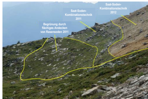
Vegetationsentwicklung nach rund vier Monaten. Ganz links im Bild wurde die Oberfläche des Geländes vollständig mit Rasensoden bedeckt. Nach einer relativ kurzen Zeitspanne sieht sie schon sehr ähnlich aus wie die umgebende Vegetation.
