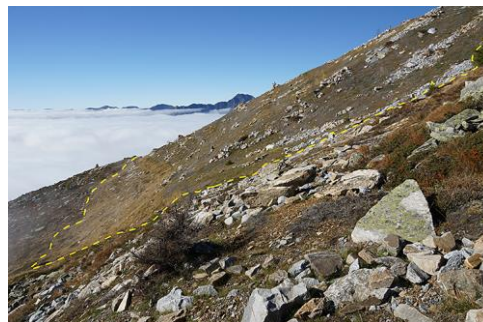
Die begrünten Flächen im Jahr 2013 (rechts und oberhalb der gelben gestrichelten Linie). Trotz der extremen Höhenlage und der relativ kurzen Vegetationsperiode ist bereits sichtbar, dass das Rekultivierungsziel erreicht wurde.
