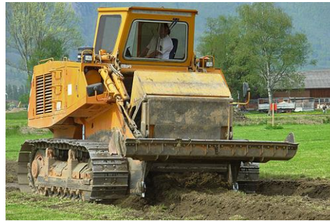
Abb. 30 > Bodenwiederherstellung mit Planierfraupe unter feuchten Bedingungen
