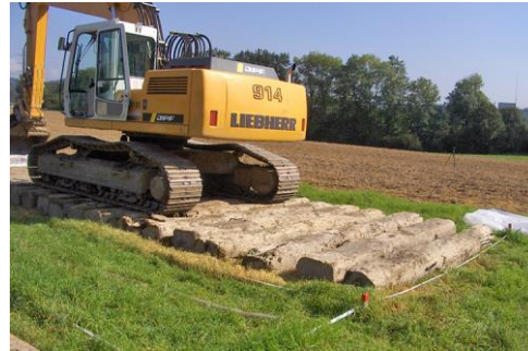
Abb. 34 > Baggermatratzen aus Rundhölzern
